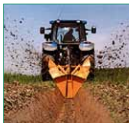
Dondi DMR 75/32 árokásó munka közben
