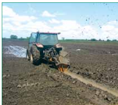
A Dondi árokásók rossz körülmények között is képesek munkavégzésre
