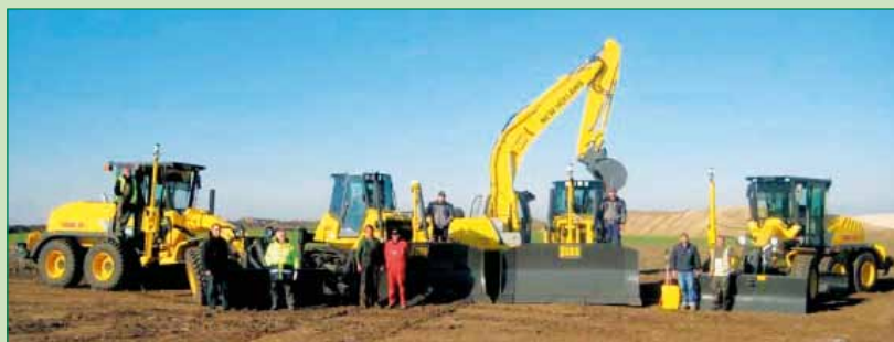
A Porr cég New Holland építőipari gépeinek flottájával építi az M6 autópálya középső szakaszát
